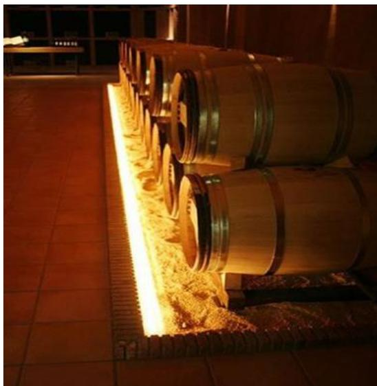
**Photo 8.** Maîtrise naturelle de l'humidité dans le chai en maintenant le lien avec le sous-sol dans la zone de stockage des fûts. Photos J. Rochard.
