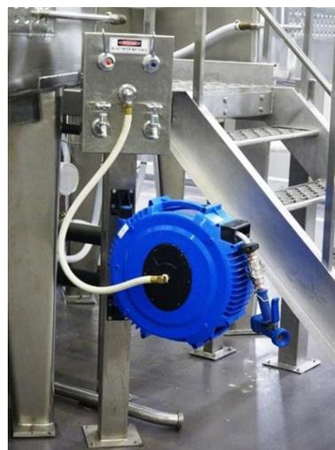
**Photo 11.** Système d'enrouleur avec un dispositif d'arrêt automatique, Photo J. Rochard.
