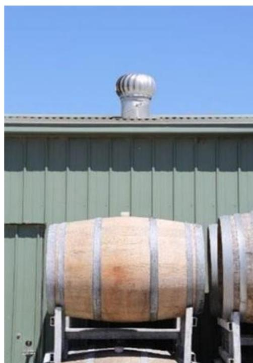
**Photo 7.** Exemple d'extraction d'air chaud sous toiture dans la région McLaren Vale en Australie, photo J. Rochard.
