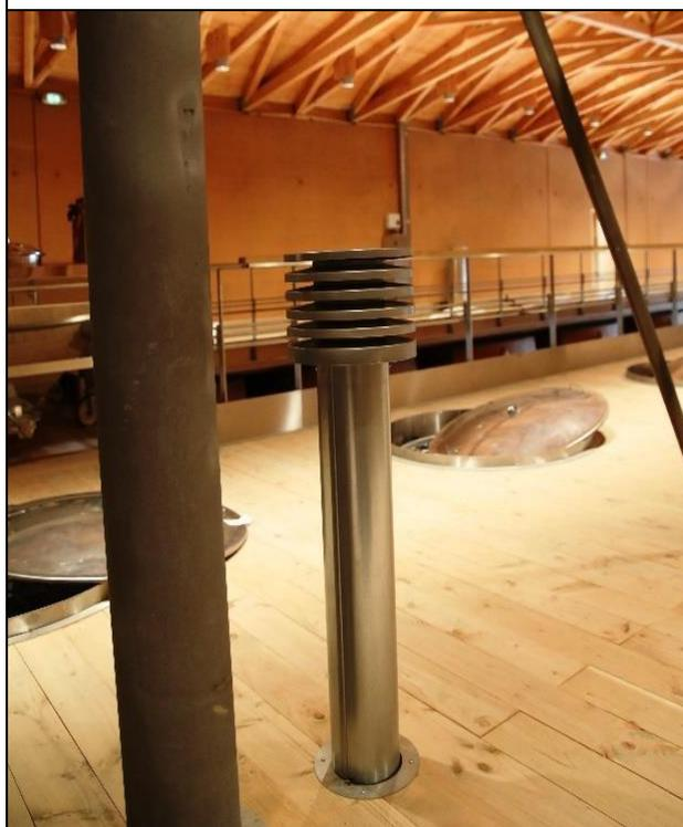
Figure 22. Exemple d'un puits canadien au Château de Malleret dans le Médoc, photos J. Rochard.
